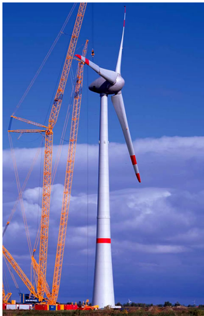
Рис. 14. Вітрова електростанція E-53
